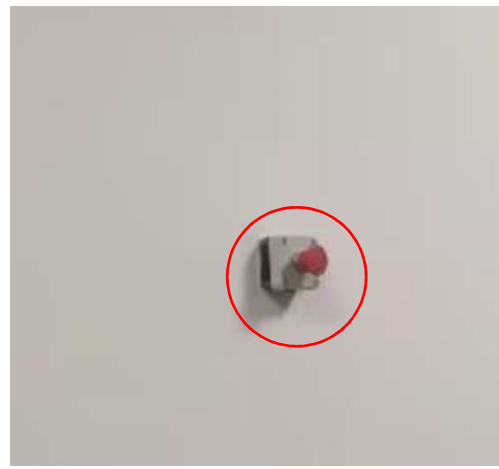
(d) 机房南侧墙体
