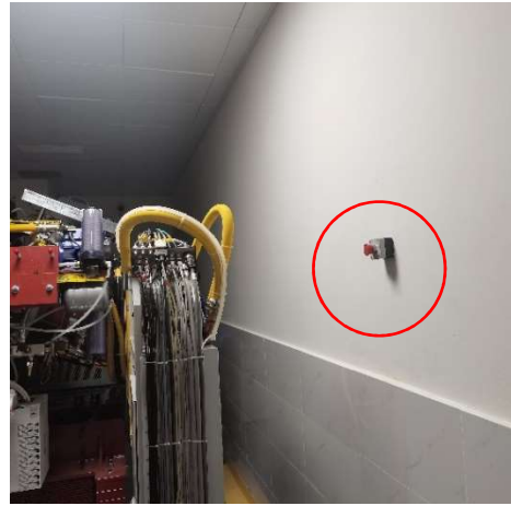
(b) 机房东侧墙体
