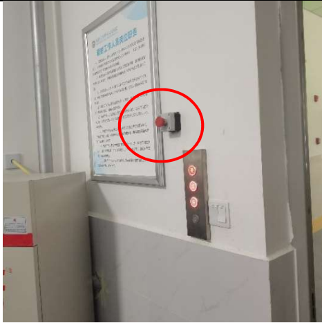
(a) 控制室南墙
